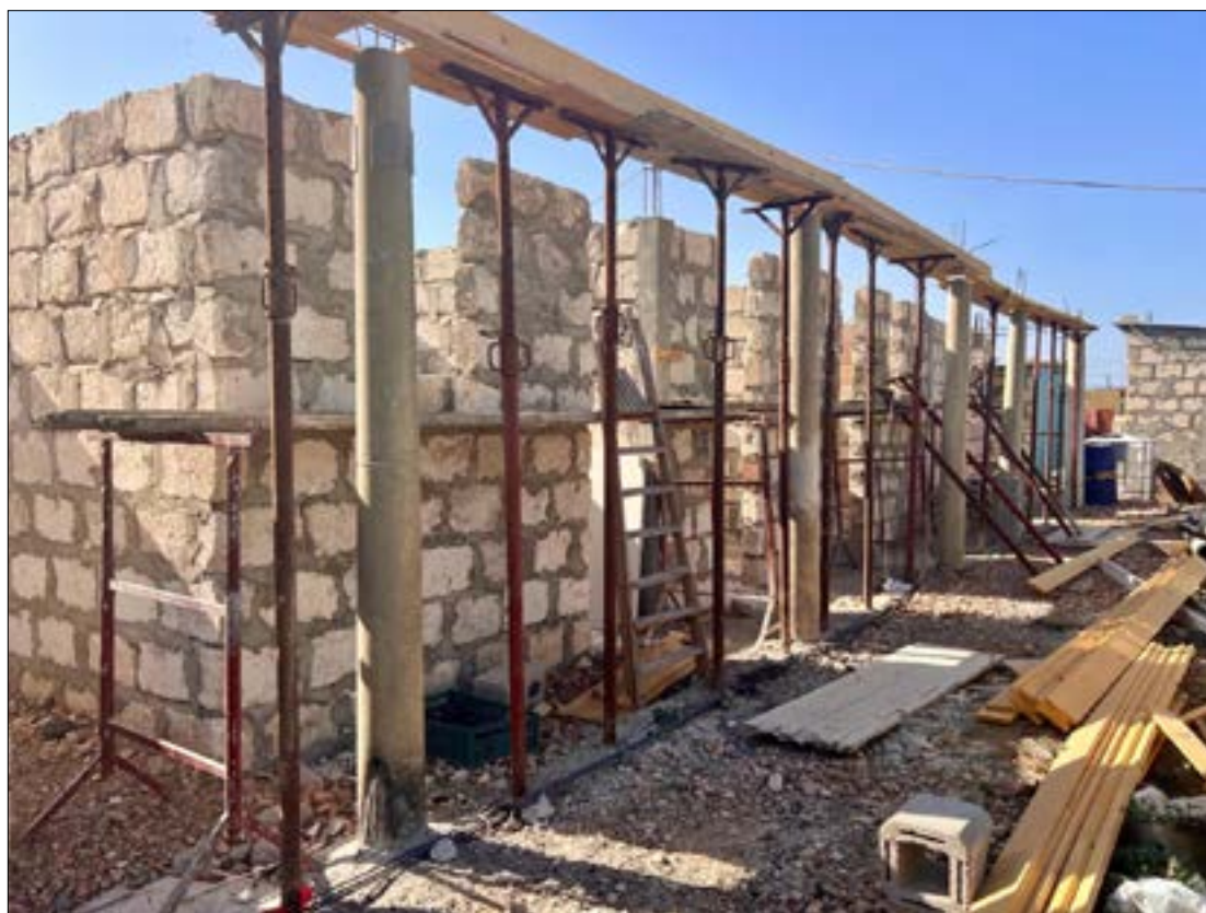
Figura 2. Abitazione in fase di costruzione, realizzata con blocchi regolari sovrapposti alternati e plinti in cemento armato (Paola Palumbo luglio 2025)
